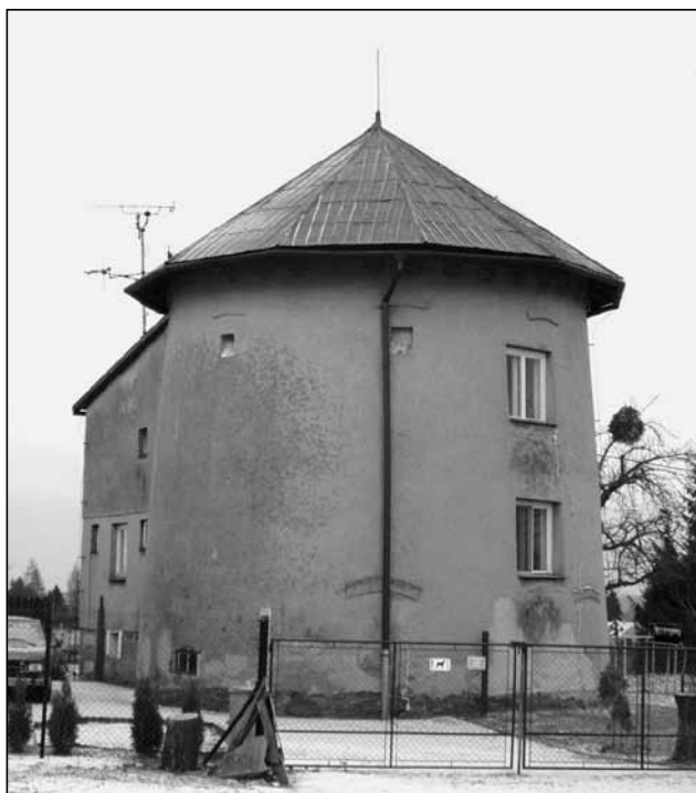
Bývalý větrný mlýn ve Studénce
